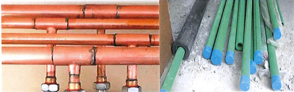
รูปที่ ๒-๕ ท่อที่ใช้ในระบบผลิตน้ำร้อนพลังงานแสงอาทิตย์ (ที่มา รายงานฉบับสมบูรณ์ โครงการศึกษาศักยภาพการใช้และประยุกต์ใช้น้ำร้อนพลังงานแสงอาทิตย์ในภาคอุตสาหกรรมและภาคบริการของประเทศไทย)
