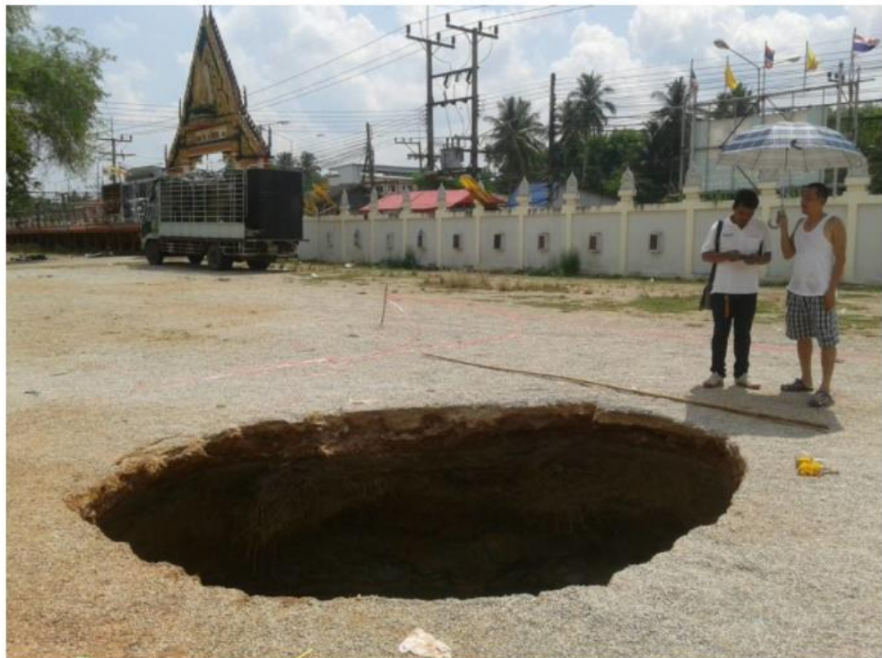
ภาพที่ ๘.๑ หลุมยุบ นครพนม
