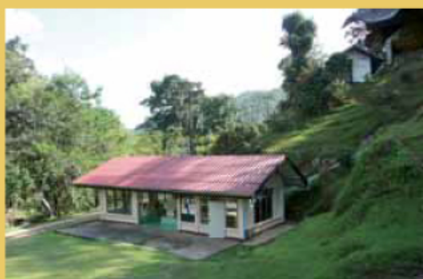
โครงการไฟฟ้าพลังน้ำขนาดเล็กบ่อแก้ว อำเภอสะเมิง จังหวัดเชียงใหม่
