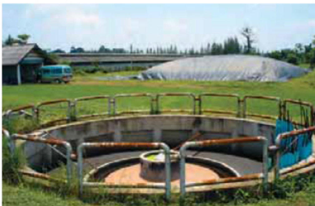
แบบ Up-Flow Anaerobic Sludge Blanket
